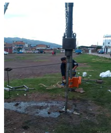
Impacto de martinete al cabezal de golpeo
