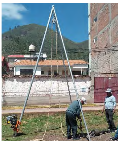
Colocación del equipo de SPT
