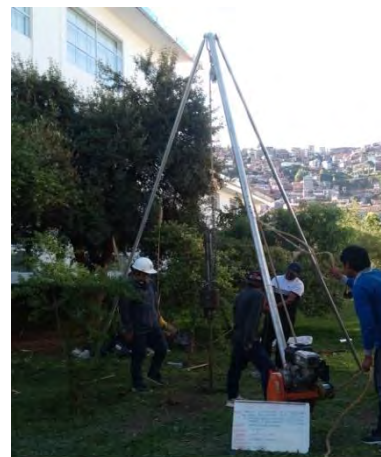
Impacto de martinete al cabezal de golpeo
