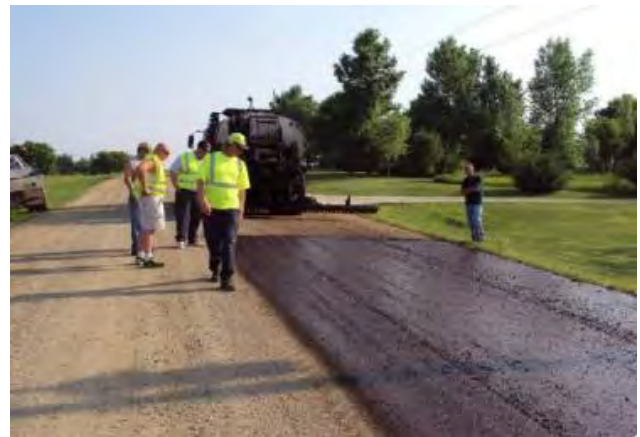
Gráfico 57. Aplicación de la Capa de Imprimación
