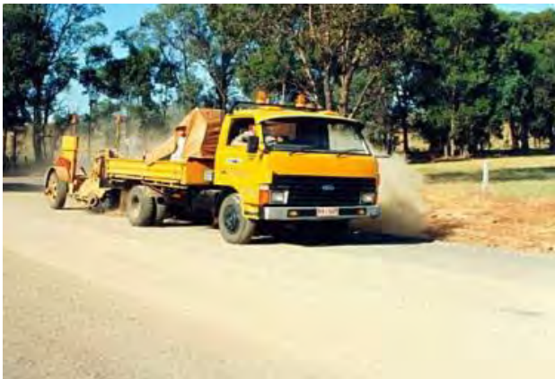
Gráfico 56. Barrido de la Base, Previo a la Colocación de la Capa de Imprimación
