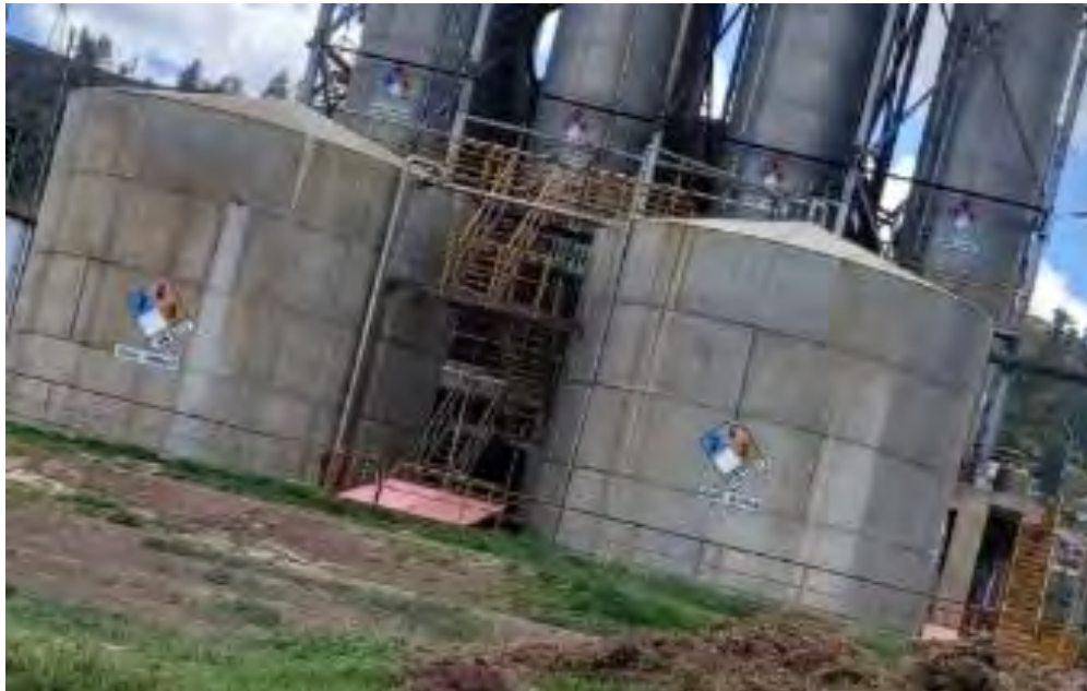
Tanques de almacenamiento de ácido nítrico
