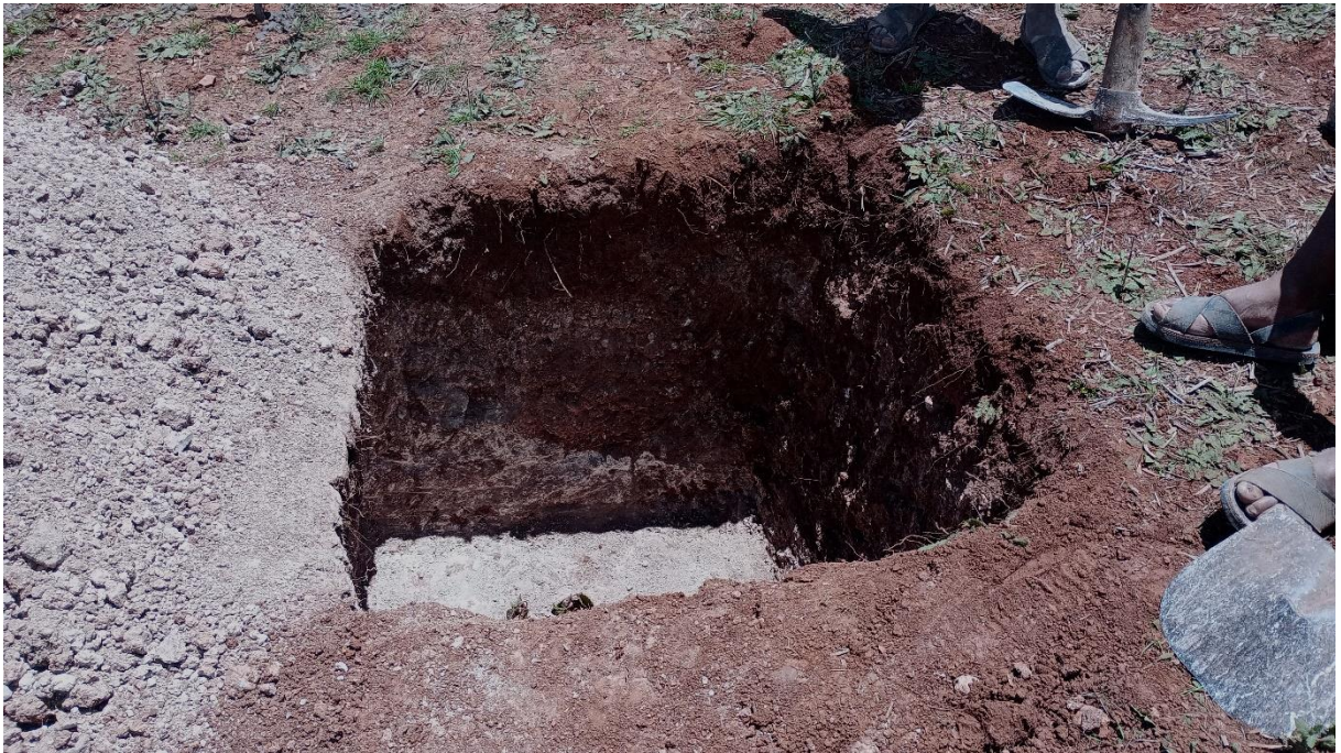
Foto N°15: Excavación de calicata y descripción en el sector de Parcco se describe estratos bien marcados con clastos redondos y sedimentos compactados se observa rocas sedimentarias y en poca cantidad de volcánicas y la humedad es moderadamente alta, Fuente: Propia
