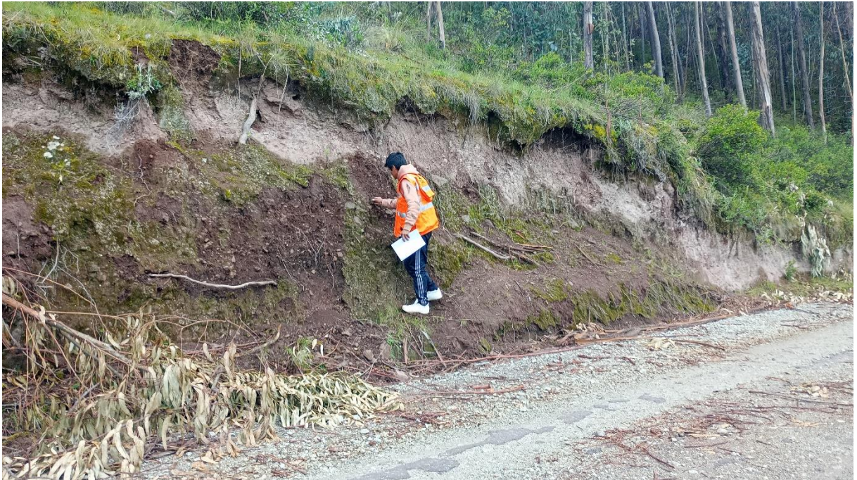
Foto N°5: Rehabilitación de carretera y deforestación. Fuente: Propia
