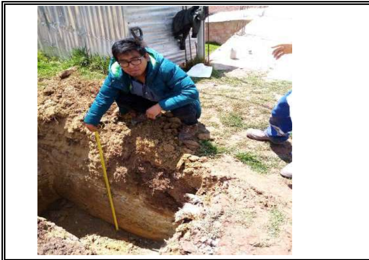
EXCAVACION DE CALICATA A.V HUAYNA PICCHU
