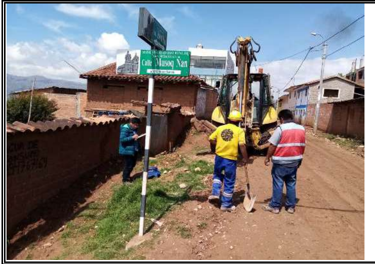
EXCAVACION DE CALICATA A.V HATUN KILLA
