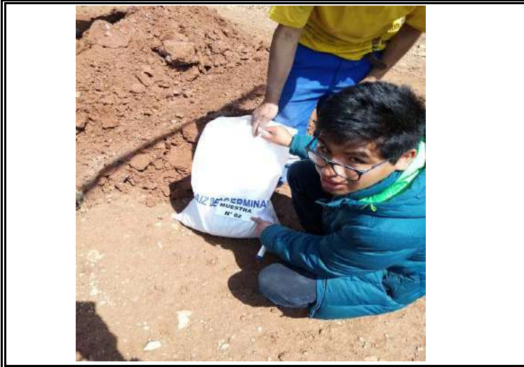
EXCAVACION DE CALICATA A.V HUAYNA PICCHU PROG 0+380
