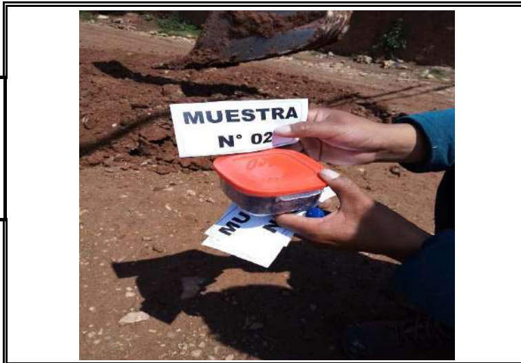
EXCAVACION DE CALICATA CALLE INTI CAHUARINA
