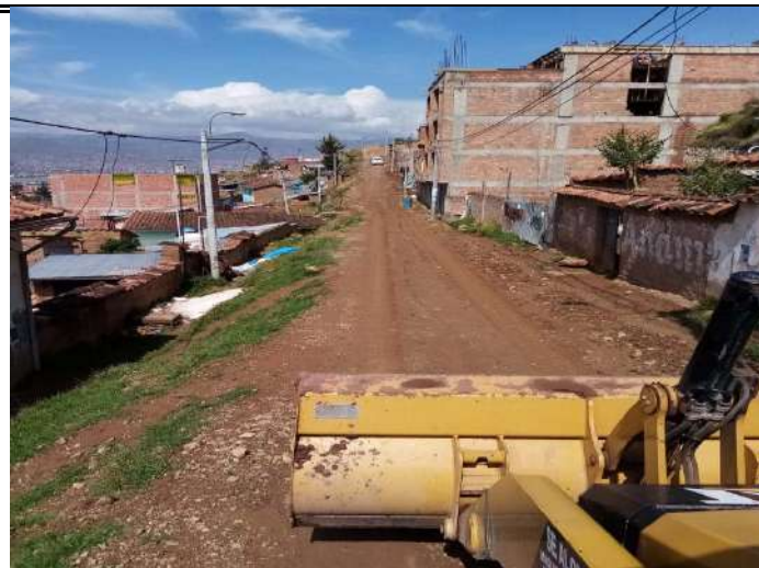
MAQUINARIA PARA EXCAVACION DE CALICATAS
