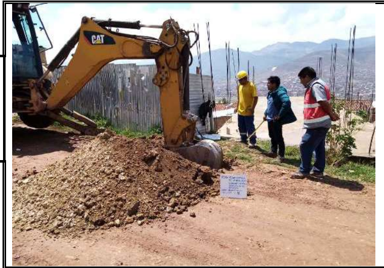
EXCAVACION DE CALICATA A.V HUAYNA PICCHU PROG: 00+040
