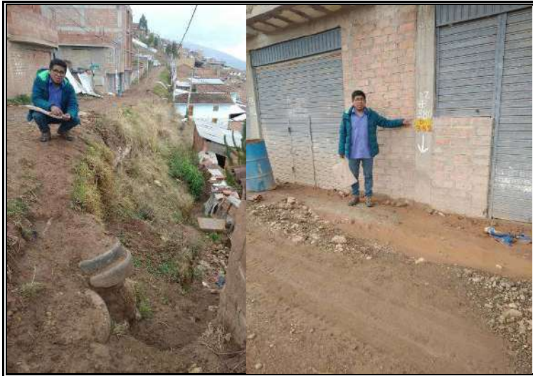
VERIFICACION DE BUZONES EXISTENTES
