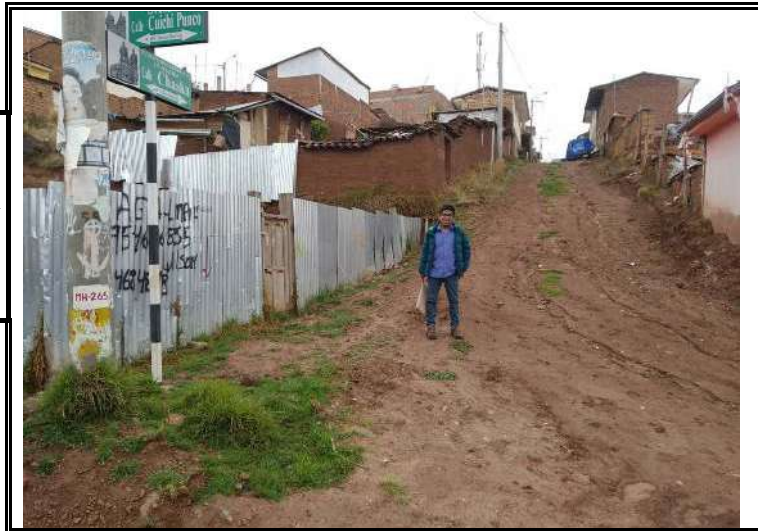
RECONOCIMIENTO PRELIMINAR CALLE CHASKA
