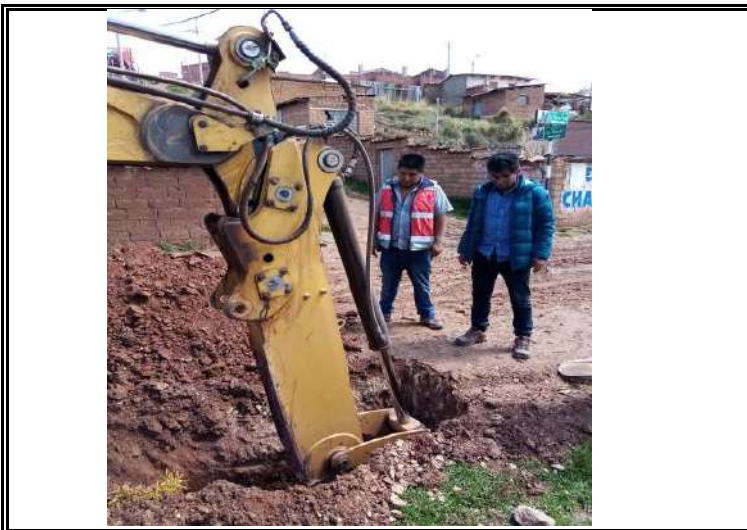
EXCAVACION DE CALICATA CALLE CHASKA
