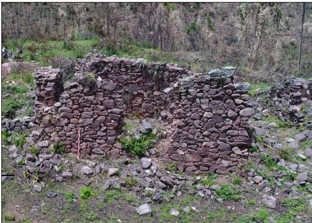
Muro frontal o anterior de la estructura arquitectónica mediana (EAM-05)
