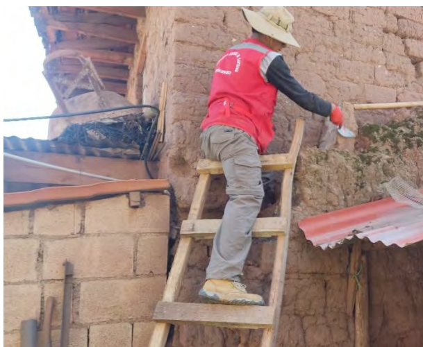
Fotografía 9: Extracción de adobes para determinar propiedades mecánicas
