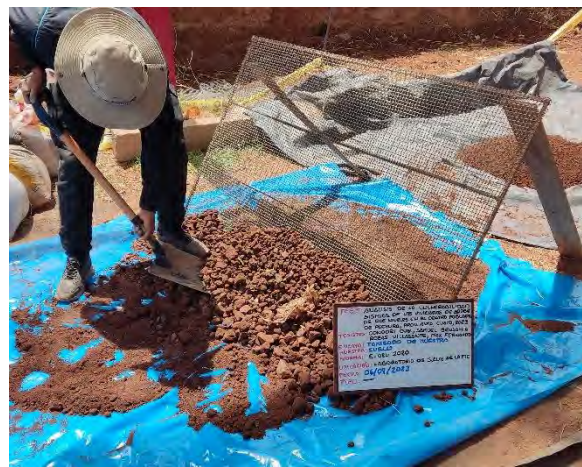
Fotografía 28: Cernido de suelo para preparación de barro
