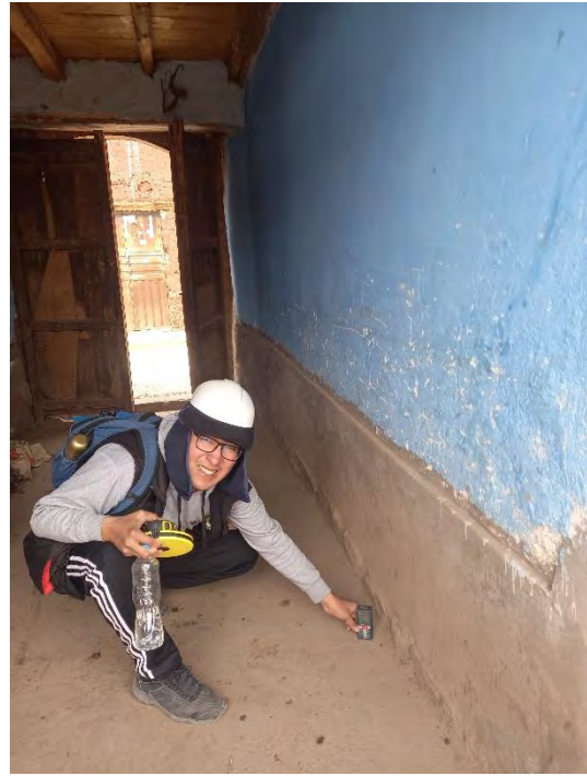
Fotografía 6: Medición de altura de entepiso del primer nivel.
