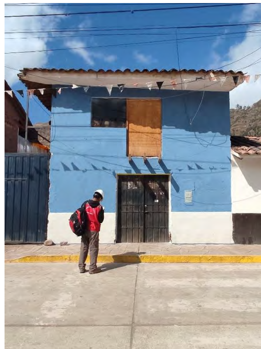
Fotografía 8: Evaluación de la fachada de la vivienda N°34
