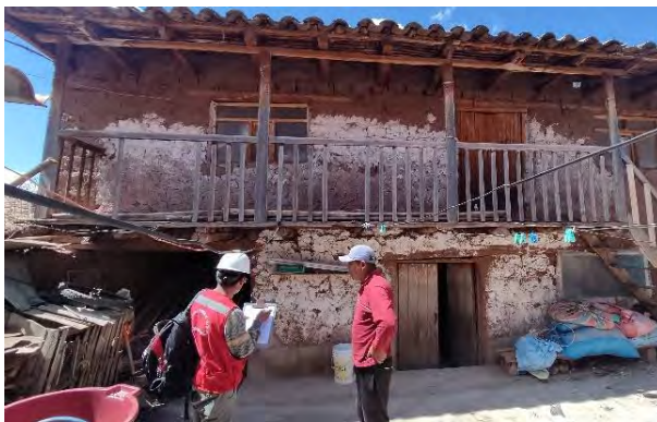
Fotografía 7: Evaluación de fachada interior
