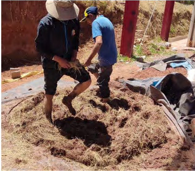
Fotografía 29: Colocado de paja sobre la mezcla de barro
