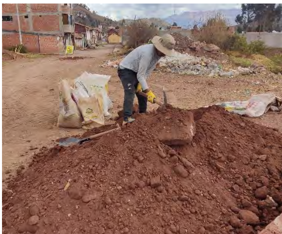
Fotografía 27: Extracción de suelo del centro poblado de Pucyura
