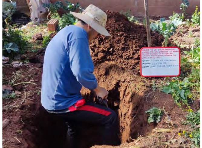
Fotografía 42: Excavación de calicata.
