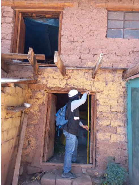
Fotografía 1: Toma de medidas de las viviendas para elaboración de planos.
