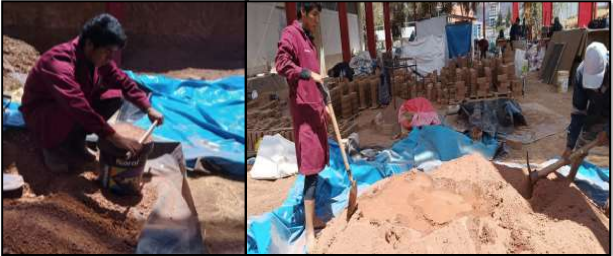
Nota. Dosificación de agua y suelo (en valdes) con apoyo de uno de los pobladores de la comunidad campesina Fortaleza Saqsaywaman para el dormido del barro.
