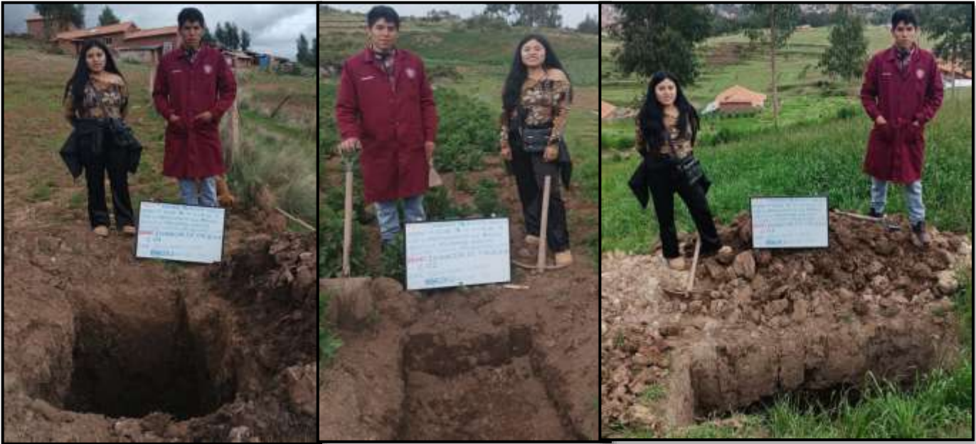
Calicata - 1 Calicata - 2 Calicata - 3
