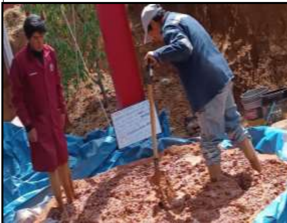
Mezclado de los materiales del barro con apoyo de uno de los pobladores de la comunidad campesina Fortaleza Saqsaywaman para el posterior dormido durante 48 horas.
