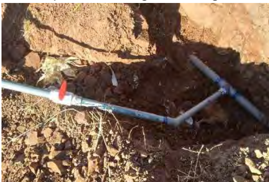
c) Conexión de tubería secundaria desde la tubería matriz primaria.
