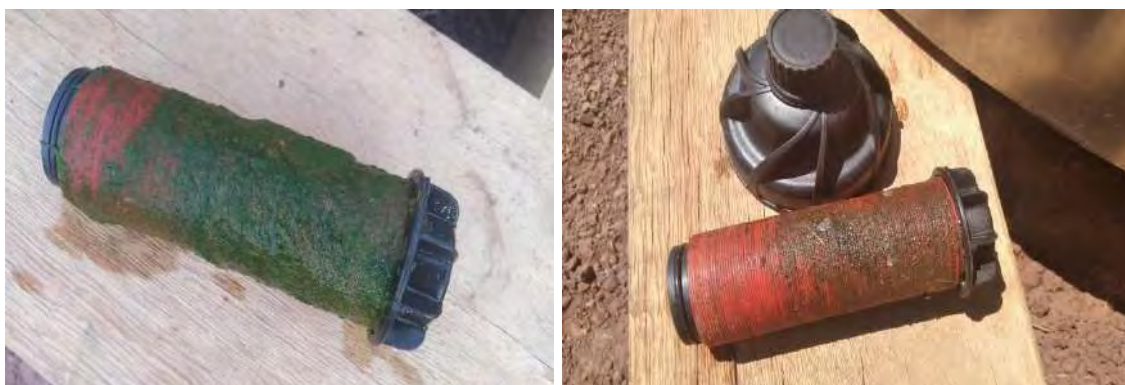
Fotografía 28. Limpieza del filtro de anillas en el arco de riego
