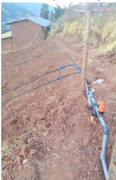
c) Instalación de arco de riego, tuberías secundarias y terciarias.
