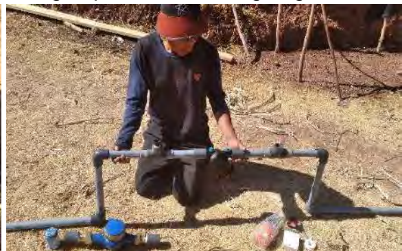
d) Ensamblado del arco de riego
