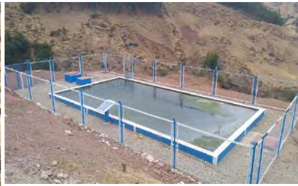
b) Reservoirio de almacenamiento de agua para fines de riego agrícola.
