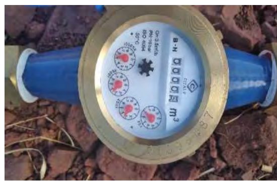
b) Medidor de agua de 32mm de chorro multiple.
