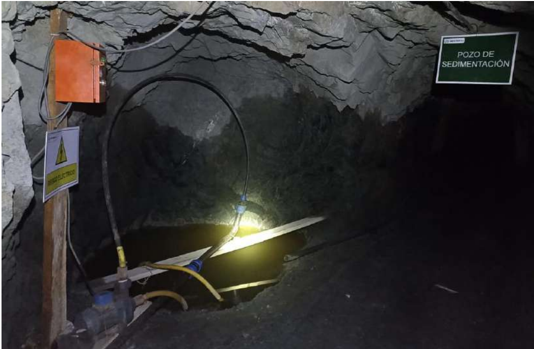
Figura 51: Pozo de sedimentación
