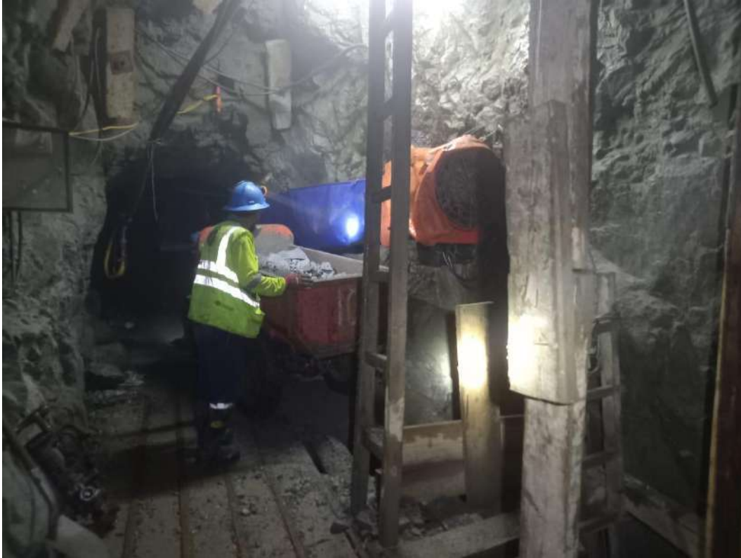
Figura 45: Inspección del material volado
