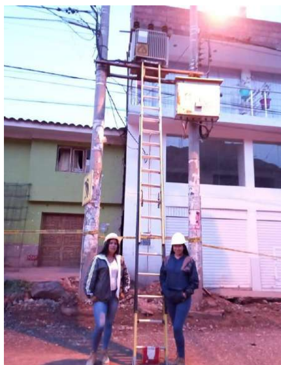
DESCRIPCION: INSTALACION DE EQUIPOS EN LA SUBESTACION ELECTRICA DE DISTRIBUCION 60027 SAYLLA
