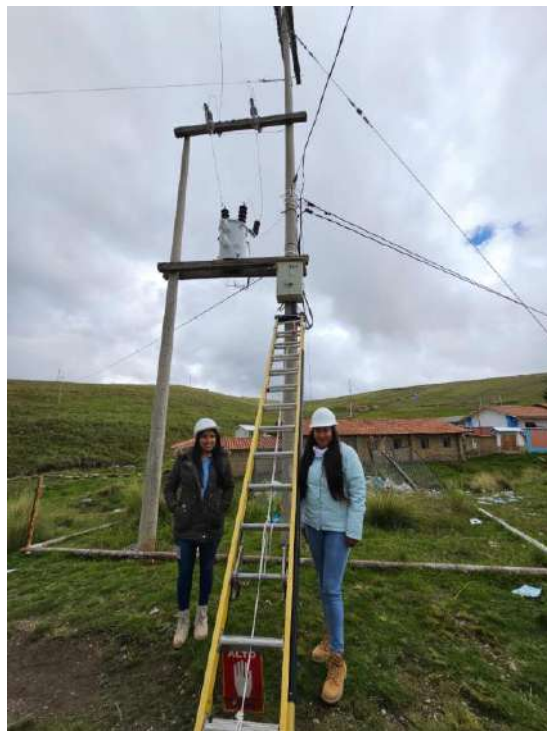
DESCRIPCION: INSTALACION DE EQUIPOS EN LA SUBESTACION ELECTRICA DE DISTRIBUCION 60155 UPIS
