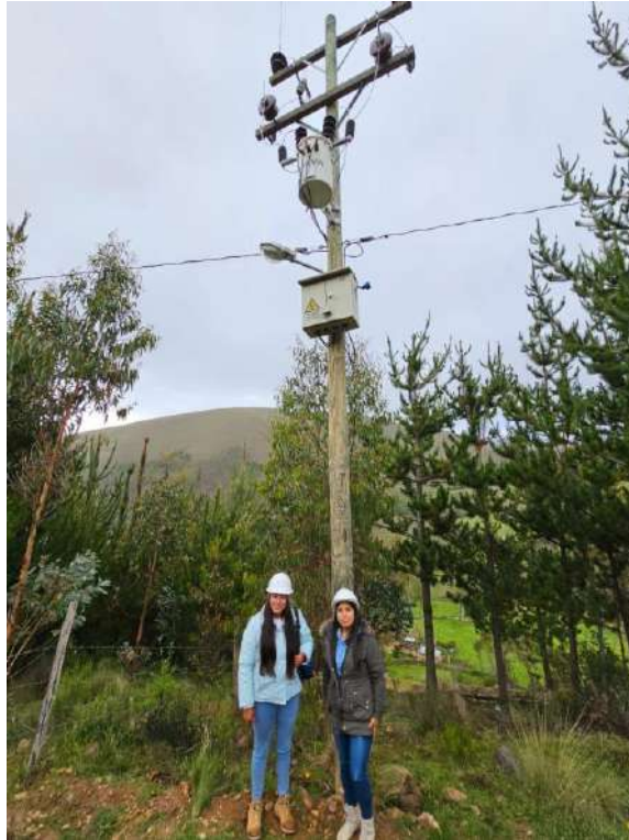
DESCRIPCION: INSTALACION DE EQUIPOS EN LA SUBESTACION ELECTRICA DE DISTRIBUCION 60290 TAYANCANI
