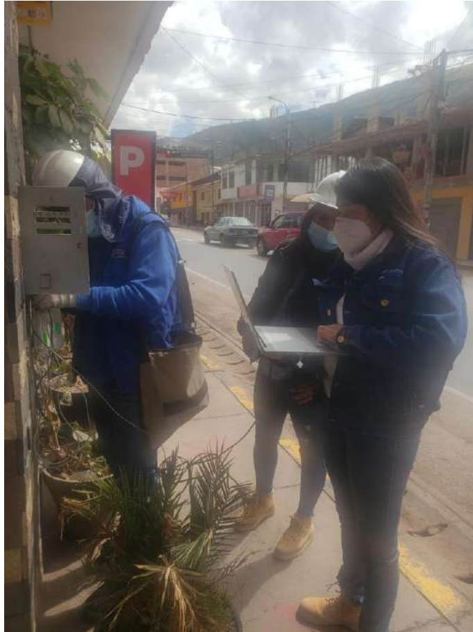
DESCRIPCION: INSTALACION DE EQUIPO DE MEDICION EN USUARIO 001-08-01-2902 CON APOYO DE PERSONAL DE LA EMPRESA ELECTRO SUR ESTE S.A.A.
