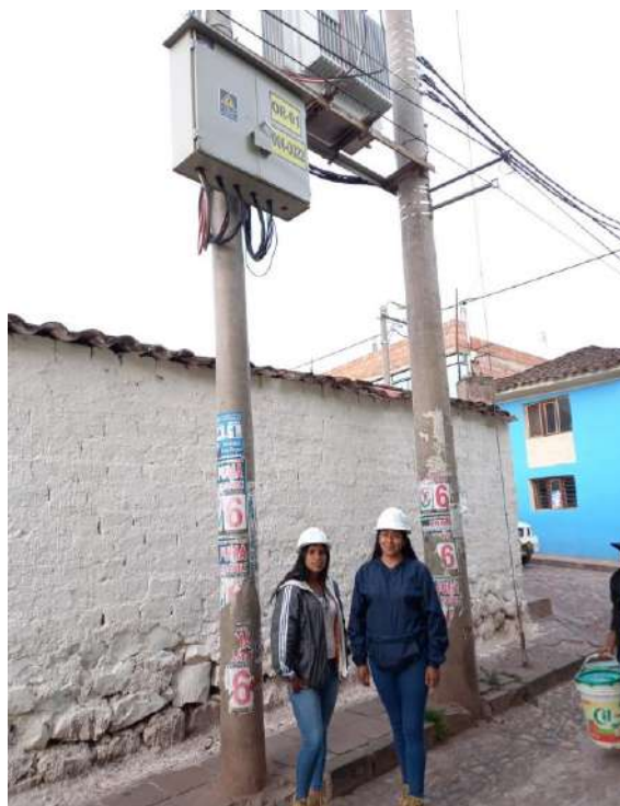
DESCRIPCION: INSTALACION DE EQUIPOS EN LA SUBESTACION ELECTRICA DE DISTRIBUCION 60022 OROPESA
