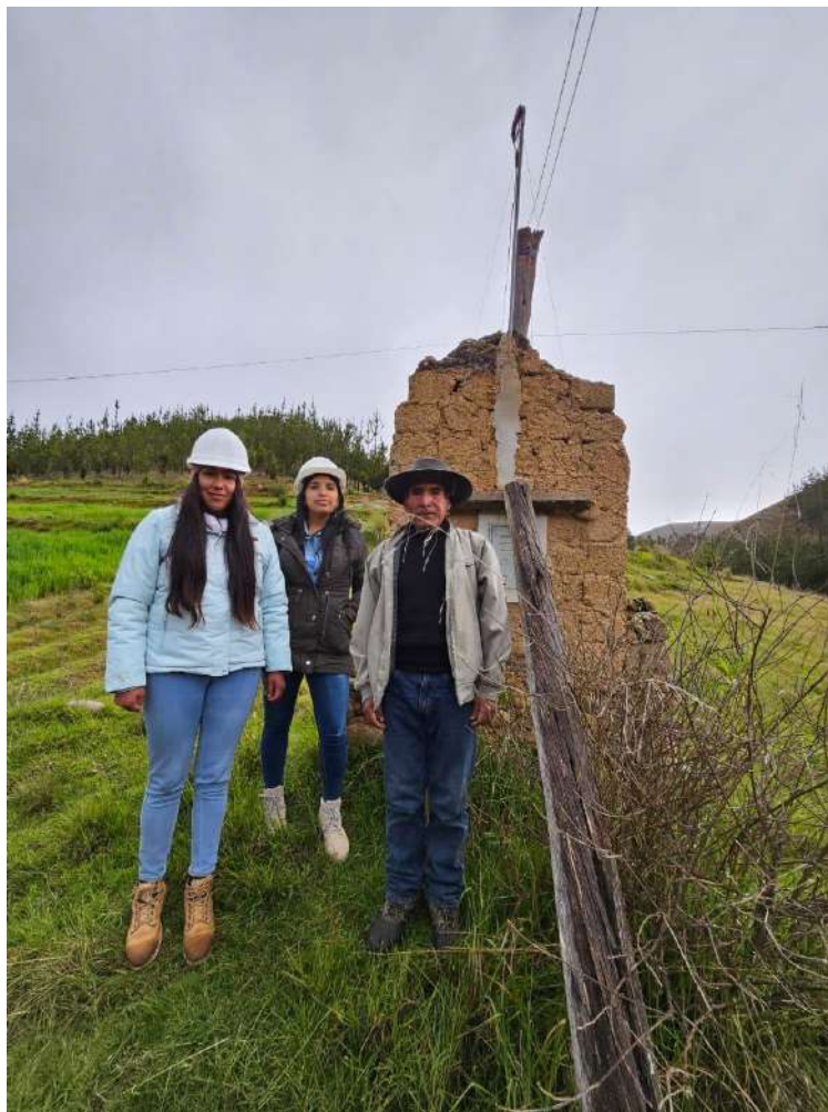
DESCRIPCION: VISTA PANORAMICA DEL SUMINISTRO 012-06-23-60 JUNTO AL PROPIETARIO
