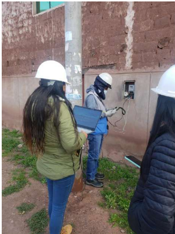
DESCRIPCION: INSTALACION DE EQUIPO DE MEDICION EN USUARIO 012-12-05-388 CON APOYO DE PERSONAL DE LA EMPRESA ELECTRO SUR ESTE S.A.A.
