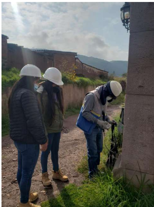
DESCRIPCION: INSTALACION DE EQUIPO DE MEDICION EN USUARIO 012-10-01-3054 CON APOYO DE PERSONAL DE LA EMPRESA ELECTRO SUR ESTE S.A.A.
