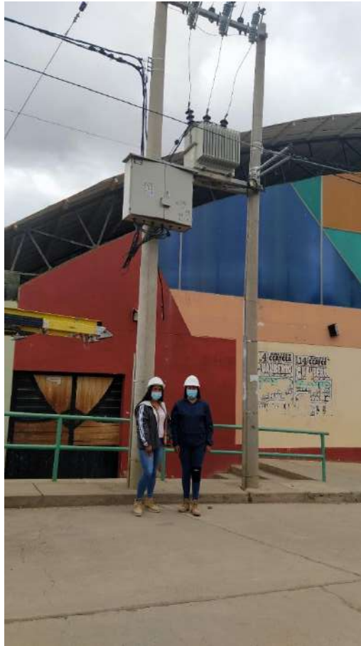
DESCRIPCION: INSTALACION DE EQUIPOS EN LA SUBESTACION ELECTRICA DE DISTRIBUCION 60042 CCATCA
