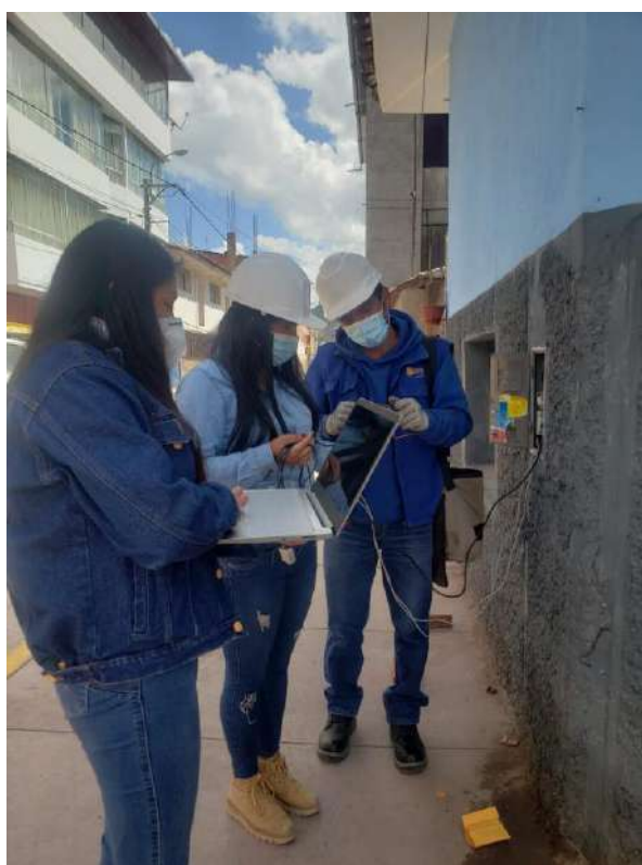
DESCRIPCION: INSTALACION DE EQUIPO DE MEDICION EN USUARIO 001-08-01-830 CON APOYO DE PERSONAL DE LA EMPRESA ELECTRO SUR ESTE S.A.A.
