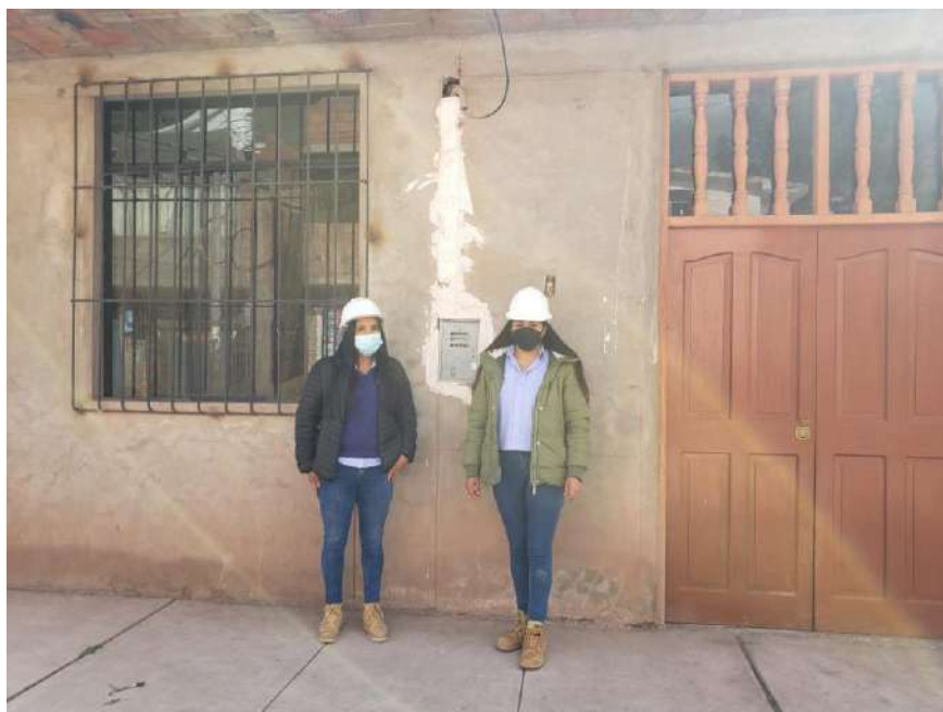
DESCRIPCION: VISTA PANORAMICA DEL SUMINISTRO 001-08-01-205
