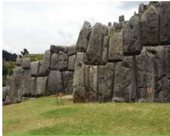
**c.** Muro aterrazado en forma de zig zag
