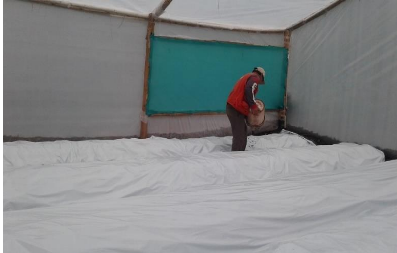
Fotografía N.º 03: Colocación del acolchado.
