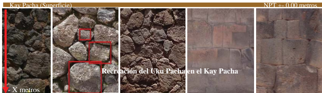
Figura 5.30: Conformación de Cimientos Inca - Raqchi, a partir de Rellenos Controlados Inca ; cuya composición no necesita una nivelación lineal, por el contrario, buscan que las gravas de variada gradación se acomoden libremente, de modo que cubran todos los espacios vacíos, asegurando máxima compactación y solidez; y esto lo advertimos en la superficie, en cada uno de los muros de la Llaqta. Fotografías, archivo personal, 2017.
