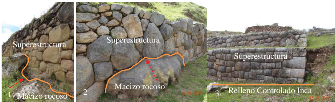
Figura 5.85: Tipos de apoyo de superestructuras en la Llaqta Inca de Saqsaywaman . Superficie de apoyo: (1) y (2), Directo sobre macizo rocoso; y, (3) sobre Rellenos Controlados Inca. “...los castillos franceses y españoles ostentaban muros verticales, permitidos por la cimentación sobre roca” (Rodríguez et.al., 1989). Fotografías, archivo personal, 2017.
