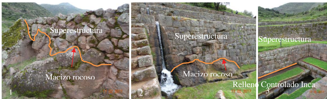
Figura 5.84: Tipos de apoyo de superestructuras en la Llaqta Inca de Tipón . Línea naranja, superficie de apoyo: (1) y (2), Directo sobre macizo rocoso; y, (3) sobre Rellenos Controlados Inca. La acertada definición del tipo de cimiento, el nivel de apoyo y, la inexistencia de asientos, constituyen las condiciones de cimentación Inca, favorecidas por la alta competencia geotécnica de los macizos rocosos de fundación. Fotografías, archivo personal, 2017.
