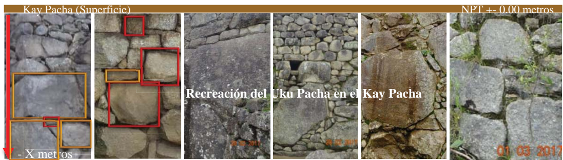
Figura 5.27: Conformación de Cimientos Inca - Machupicchu; a partir de Rellenos Controlados Inca ; notamos en las imágenes, la extensión de la composición de los cimientos en el Kay Pacha (superficie); resaltando en la base piezas de gran tamaño, que gradualmente van disminuyendo, conforme alcanzan la coronación del muro; pero, siempre alternadas con piezas menores para asegurar óptima compacidad, sin vacíos, garantizándose la solidez y estabilidad necesarias. Fotografías, archivo personal, 2017.
