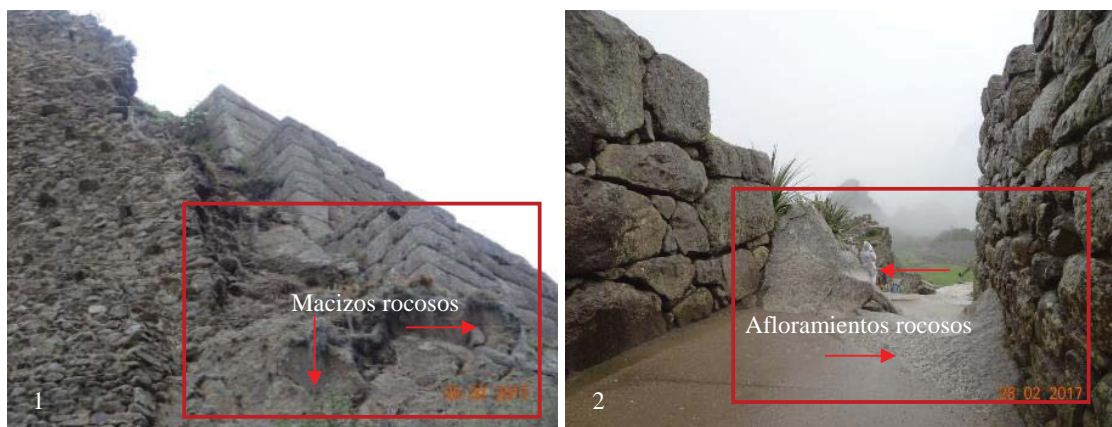
Figura 2.5: Macizos y afloramientos rocosos, en Llaqtas Incas. Recuadros rojos muestran: (1) Macizos rocosos de los suelos de fundación, Llaqta Inca de Ollantaytambo; (2) Afloramiento rocoso, Llaqta Inca de Machupicchu. Fotografías, archivo personal, 2017.
