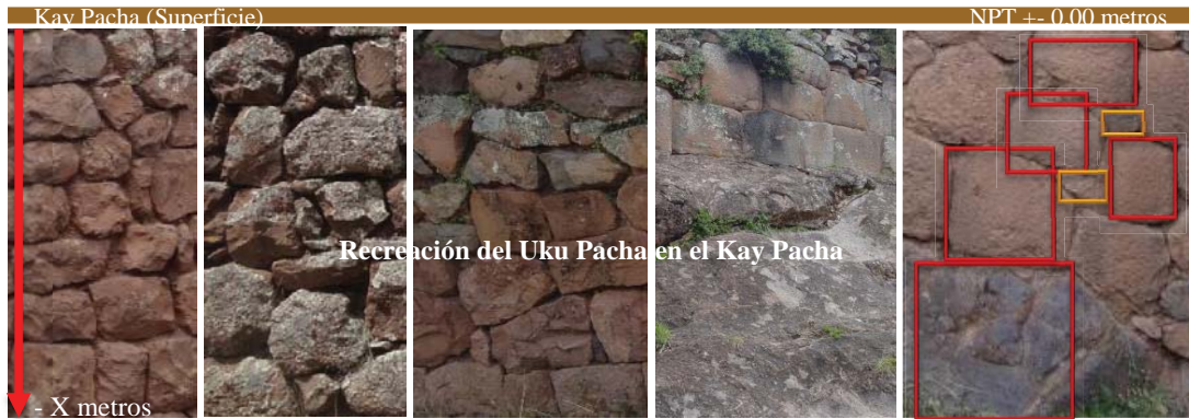
Figura 5.29: Conformación de Cimientos Inca - Písaq, a partir de Rellenos Controlados Inca , los mismos que desde el Uku Pacha (sub suelo), se extienden hasta el Kay Pacha (superficie), mostrándonos, cómo se conforman y el nivel de compactación que presentan, utilizándose para ello, gravas de gradación variada. Fotografías, archivo personal, 2017.
