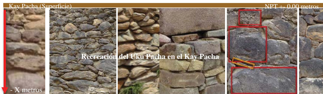
Figura 5.28: Conformación de Cimientos Inca – Ollantaytambo; a partir de Rellenos Controlados Inca ; en el caso de la Llaqta Inca de Ollantaytambo , advertimos en el Kay Pacha (superficie), a lo largo de toda la Llaqta, la extensión de la composición formal de los cimientos Incas desde el Uku Pacha (sub suelo), constituidos en la base (- X metros) por el macizo rocoso, representado por piezas de gran tamaño, seguido de bolones de gradiente descendente, que incluyen piezas pequeñas que llenan los vacíos, hasta alcanzar la coronación del muro. Técnica operada por los Incas, en el Uku Pacha y Kay Pacha. Fotografías, archivo personal, 2017.
