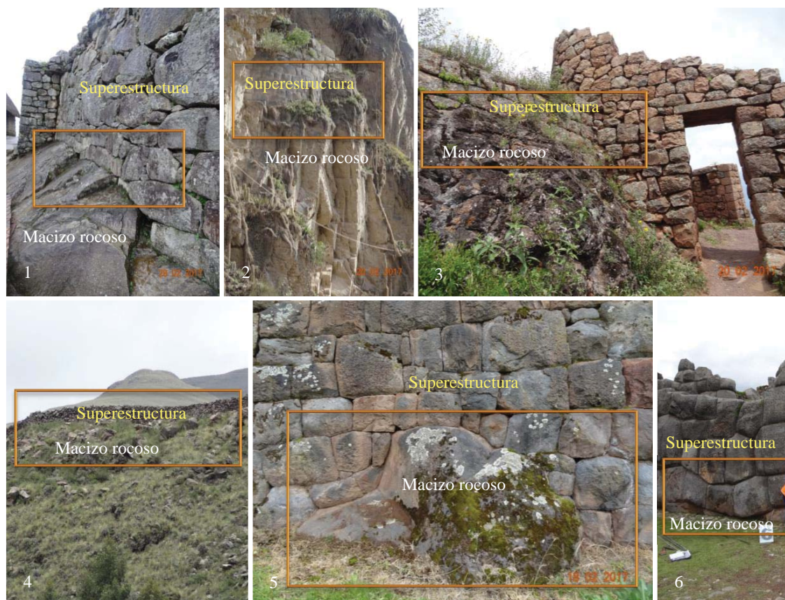
Figura 5.26: Sistema: Superestructura - macizo rocoso; donde el muro Inca hace las veces de cimiento en su base de contacto directo con el macizo rocoso. (1) Machupicchu, (2) Ollantaytambo, (3) Písaq, (4) Raqchi, (5) Tipón, (6) Saqsaywaman. Pachamama con mínimo impacto, es una estrategia Inca para la supervivencia de las Llaqtas; por ello, sí se podía cimentar directamente en el macizo rocoso, así lo hacían. Fotografías, archivo personal, 2017.
