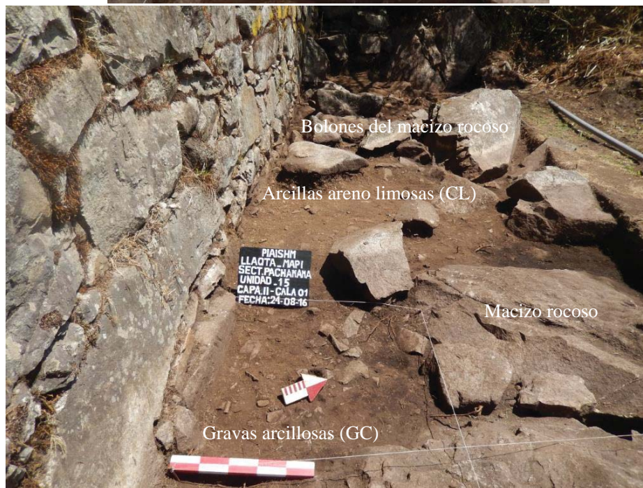
Figura 5.75: Relleno Controlado Inca, RCI – Muros de contención - Machupicchu. Conformado por Capas de Bolones del macizo rocoso; Gravas bien graduadas; Gravas arcillosas (GC) y Arcillas areno limosas (CL), que sellan y compactan las capas, cuyo espesor promedio es 0.70 m. Fotografías, archivo Jefatura Santuario Histórico de Machupicchu, 2016.
