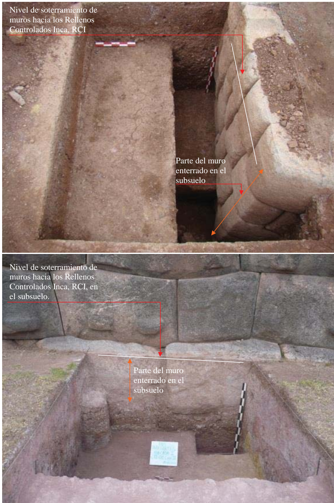
Figura 5.79: Relleno Controlado Inca, RCI - Soterramiento y confinamiento de muros. La finalidad es lograr rigidez suficiente a la estructura suelo-cimiento-superestructura. Fotografías, Proyecto de Investigación Arqueológica Sector Baluartes – Saqsaywaman 2010.
