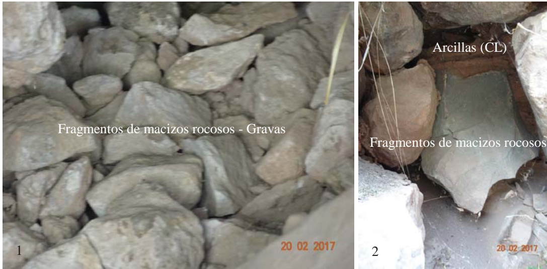
Figura 5.87: Rellenos Controlados Inca, en sus contextos originales II - Písaq. (1) Capas próximas a los macizos rocosos de fundación, constituidas por fragmentos de roca de diferente tamaño; (2) capas constituidas por fragmentos de roca, con presencia de arcilla como material ligante. Las cimentaciones superficiales, pueden ser catalogadas “por su forma de trabajo... como continua bajo muro” (Rodríguez et.al., 1989, p. 89). Fotografías, archivo personal, 2017.
