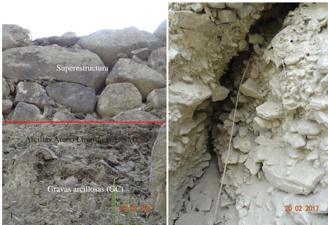
Figura 5.90: Rellenos Controlados Inca, en sus contextos originales II - Ollantaytambo. (1) Capas superiores conformantes del Estrato 1 (E1, Relleno Controlado Inca), constituidas por Arcillas Areno Limosas (CL-SM), que además de coadyuvar en la compactación del relleno, posibilita homogeneizar las superficies de apoyo de las superestructuras Incas; la capa subyacente está constituida por Gravas Arcillosas (GC), cuya función es más bien ya de soporte inicial de las cargas que se transmiten hacia las gravas bien graduadas (GW), fragmentos de roca o bolones de roca de diverso tamaño, hasta alcanzar al macizo rocoso, que constituye el Estrato 2 (E2); (2) detalle de la capa constituida por Grava Arcillosa (GC); el espesor o potencia de las capas está en función a la morfología del relieve. Fotografías, archivo personal, 2017.
