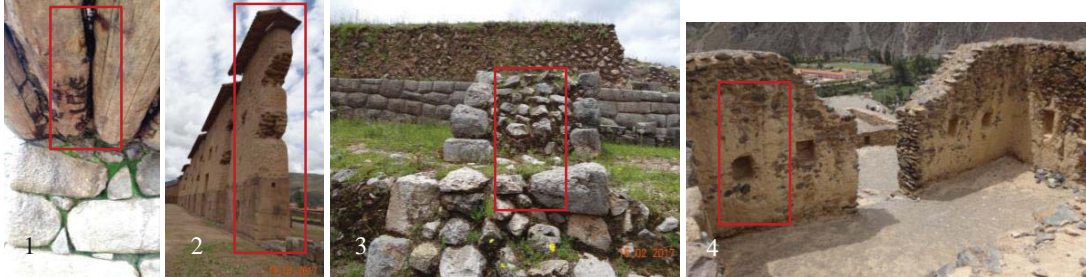
Figura 5.13: Características constructivas de Llaqtas Incas; (1) Dintel de madera (Machupicchu); (2) Perla de adobe, sobre cimiento de piedra (Raqchi); (3) núcleo de muro (Saqsaywaman); (4) enlucido de muros con barro (Ollantaytambo). Aligerar el peso propio de las superestructuras Incas con la utilización de madera y, el relleno de los muros pétreos con unidades más pequeñas, son algunas de las estrategias utilizadas. Fotos, archivo personal, 2017.
