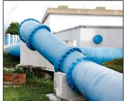
Figura 19: Tubería de hierro fundido dúctil
