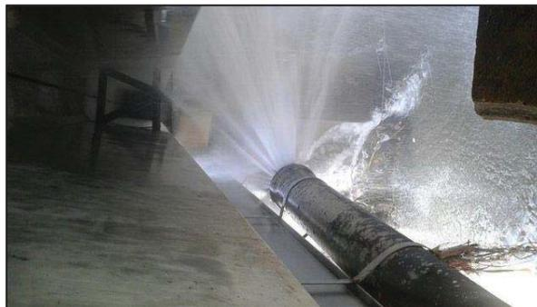
*Figura 8: Rotura de tubería por presión excesiva*
