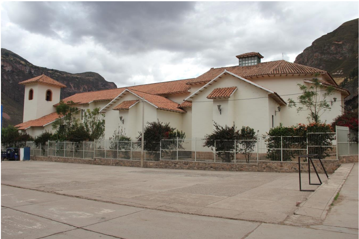
Fotografía: N° 04 Muro de la Epístola
