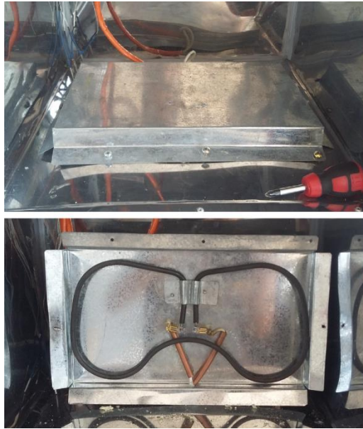
Figura 4. 23: Instalación de la resistencia de Nichrom en el plato de transferencia.
