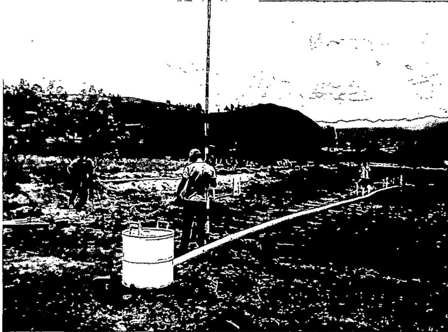
*Fotografía 15. Instalación de estacas en cabecera de campo*
